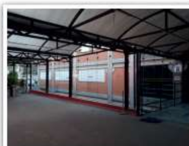
Fechamento em vidro do corredor de acesso aos Blocos B e C.
