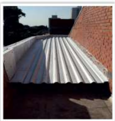
Troca de telhado das caixas de escada do Bloco A
