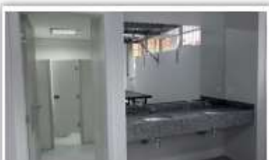
Reforma e adequações nos Sanitários do Subsolo do Bloco B.
