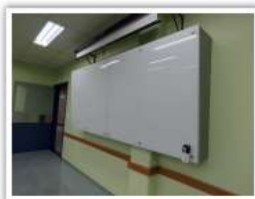
Instalação de lousa de vidro em todas as salas
