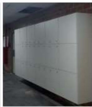
Instalação de Novos Escaninhos no Subsolo do Bloco B e C
