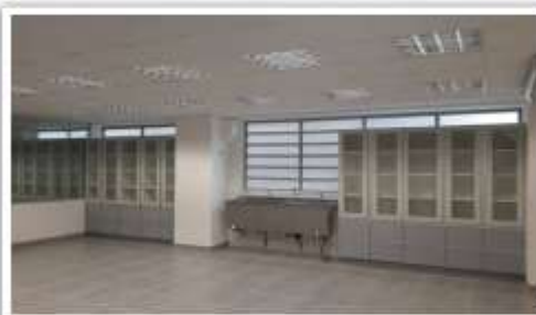
Reforma dos Laboratórios BS 03 e BS 04
