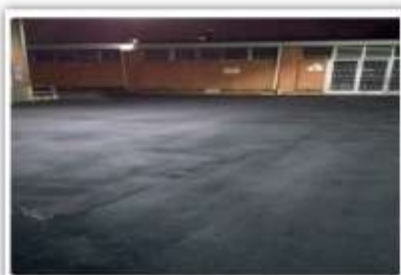
Recapeamento do asfalto do estacionamento.
