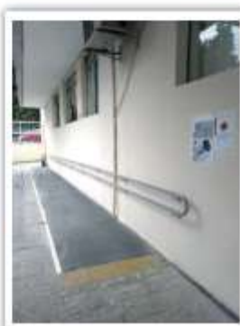
Acessibilidade: Adequação na Rampa principal; Adequações nos Corrimãos.
