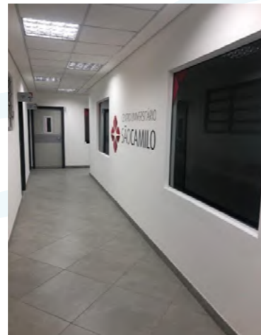
Revitalização e ampliação das Tutorias no 1º andar do bloco C
