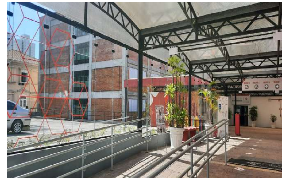
Fechamento em vidro na entrada principal do campus
