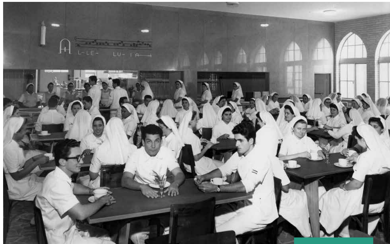
Refeitório da Santa Casa
